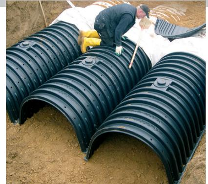
Das **DRAINMAX®** Sickertunnel-System besteht aus großvolumigen, leichten Kunststoffschalen zur Speicherung und anschließenden Versickerung von Niederschlagswasser. Die Profile haben ein Rückhaltevolumen von 100%. Im Vergleich zu einer Kiesrigole (Rollschotter) wird somit weniger als 1/3 des herkömmlichen Bauraumes benötigt.
