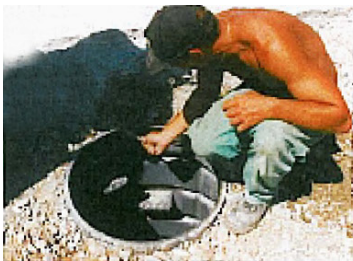
Aufbringen von Gleitmittel auf das Teleskop - Spitzende
