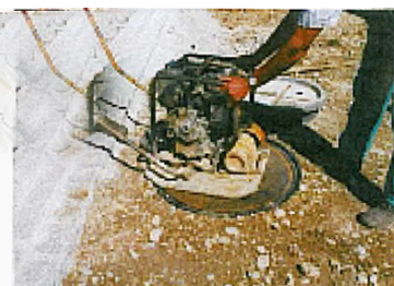
Einrütteln des Teleskops in die Trageschicht
