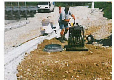
Unterfüllen des Aufsatzstückes und Verdichten
