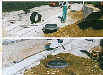
Teleskop ca. 30-50mm über die entgültige Lage positionieren
