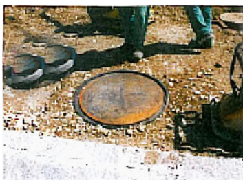
Einsatz einer Eisenplatte
